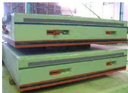
図-1 SBL セグメント継手
